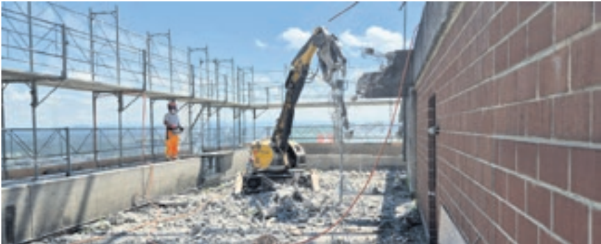
Die zweite Bauetappe des Juradorfes in Wiedlisbach ist in vollem Gange und soll bis Ende Jahr abgeschlossen sein. (Bilder: zvg)
