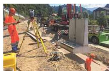
Ein Beispiel für eine Bau-Ingenieurvermessung in Trubschachen.
