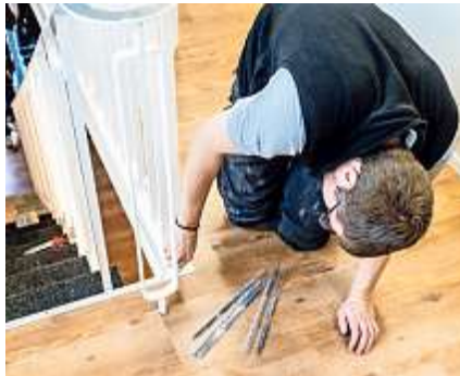
Einblick in die Tätigkeit eines Bodenlegers: Eine Treppe in einem Privathaus erhält eine neue Oberfläche.
